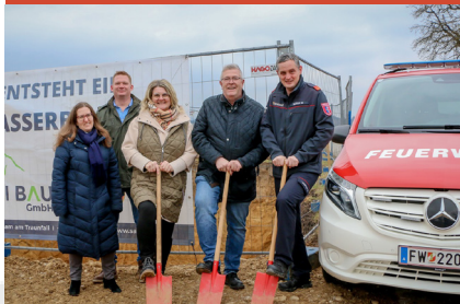
Spatenstich Löschwasserbehälter | 06. Februar
